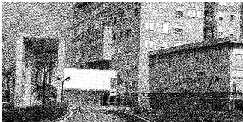
L'ospedale di Legnago al centro dei lavori del Consiglio comunale aperto con l'assessore Luca Coletto
